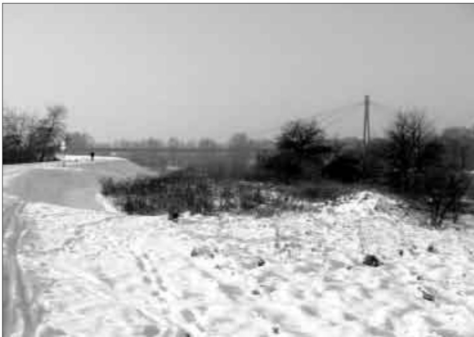
Ryc. 24. Rurociąg doprowadzający do Krakowa wodę ze zbiornika na Rabie w Dobczycach; po lewej stronie widoczna ścieżka rowerowa biegnąca wałami Wisły. Fot. J. Pociask-Karteczka
