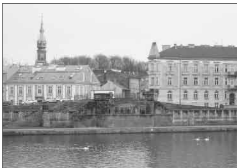
Ryc. 14. Przyczółek mostu Karola zniszczonego w czasie powodzi w 1813 r. W tym miejscu planuje się budowę kładki pieszo-rowerowej. Fot. J. Pociask-Karteczka
