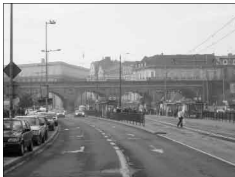
Ryc. 5. Wiadukt kolejowy przy ul. Grzegórzeckiej pełniący niegdyś rolę mostu na Starej Wisłę (obecnie element Krakowskiego Szlaku Techniki utworzonego 6 kwietnia 2006 r.)
